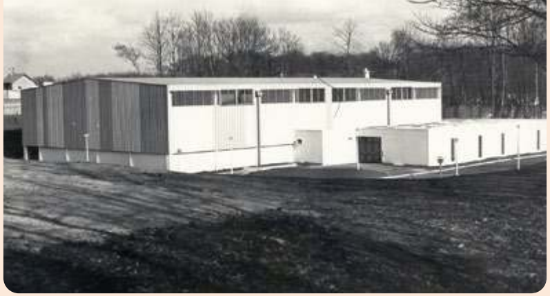
Le COSEC à la fin des travaux de construction [1976], Archives municipales 7Fi125.
